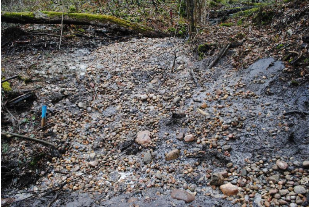
Hochplombe mit Lesesteinschüttung
