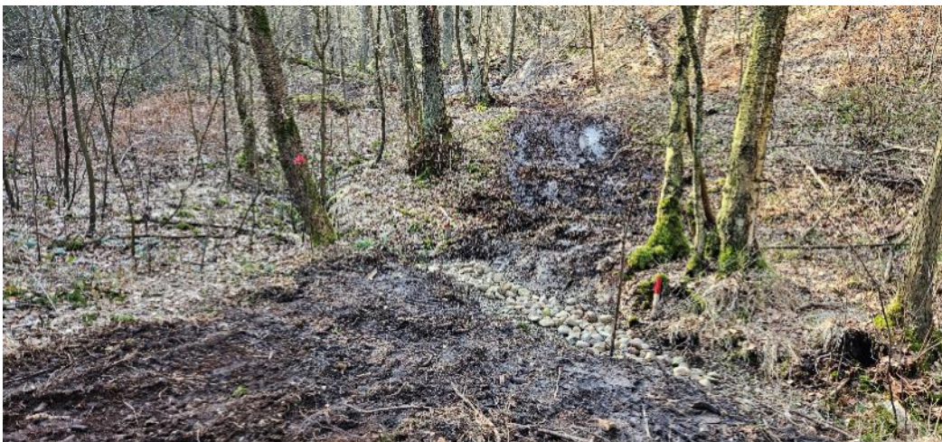
Sohlschwelle im Bereich Bauzufahrt
